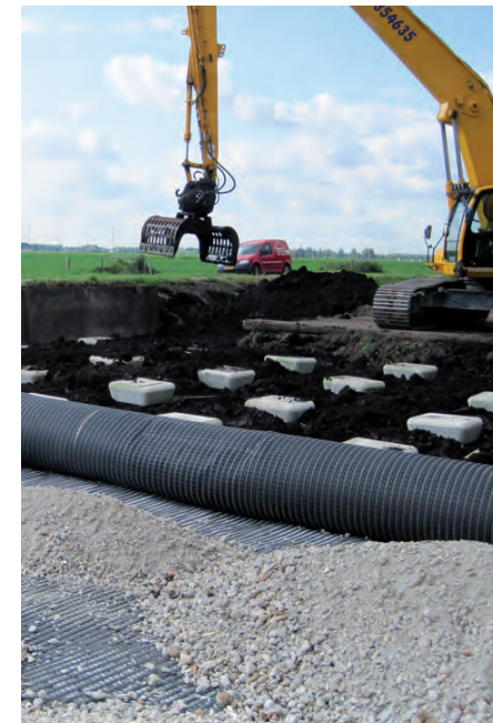
Mise en œuvre d'un renforcement géosynthétique sur inclusions rigides (autoroute N 210, Pays-Bas)
