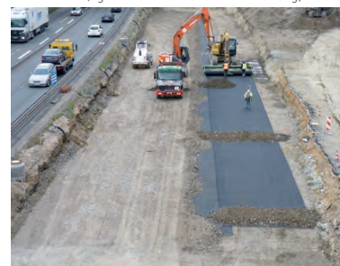
Mise en œuvre d'un système parachute anti-effondrement (nœud autoroutier ouest de Bochum, A 52, Allemagne)
